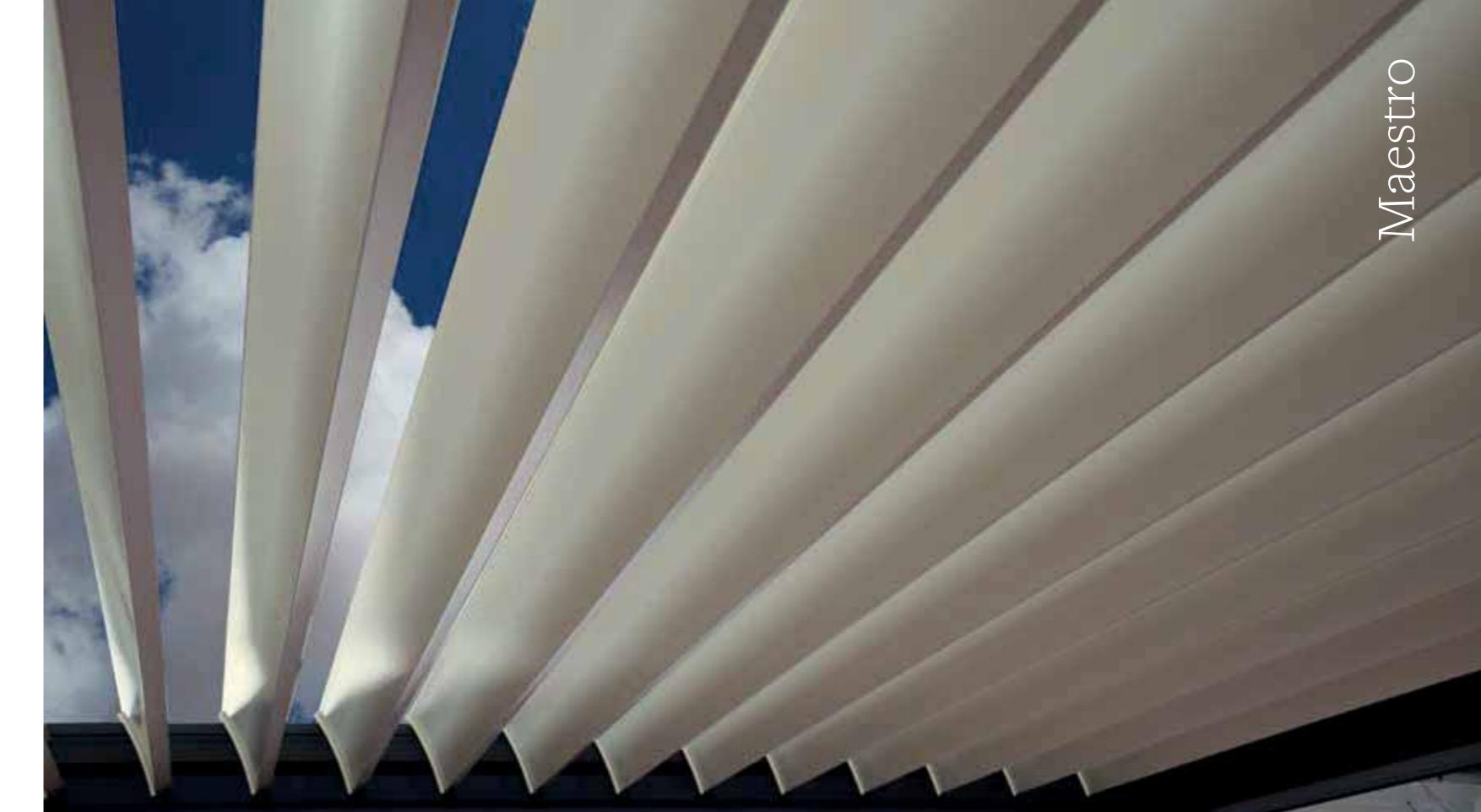
Il motore di Maestro è nascosto alla vista e le lamelle, quando completamente aperte, rimangono visibili all'esterno per soli 9,5 cm.
